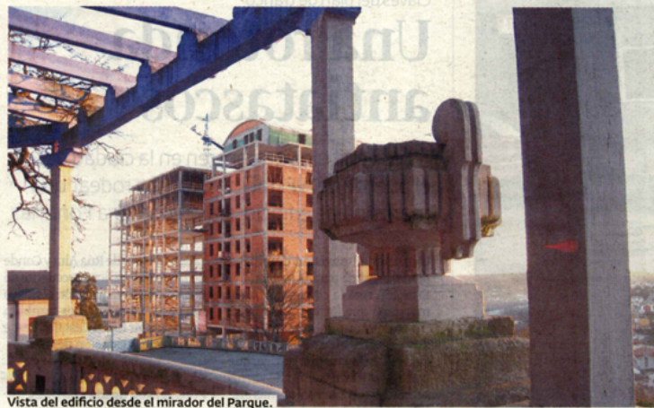
Vista del edificio desde el mirador del Parque.
